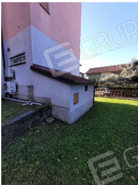
Foto 16- Locale tecnico esterno (non indicato nei progetti)
